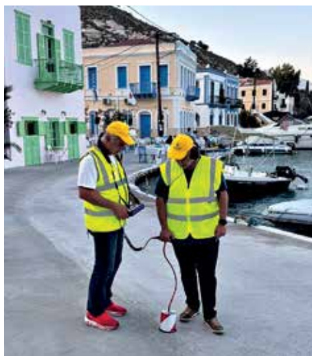
Τεχνικοί της ΕΥΔΑΠ χρησιμοποιούν εξειδικευμένο εξοπλισμό (γαιόφωνα) για τον εντοπισμό αφανών διαρροών στο δίκτυο ύδρευσης του Καστελλόριζου.
